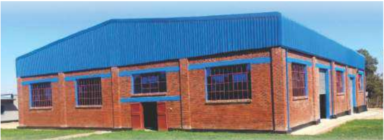
New Mutoko Bio-diesel factory shell
